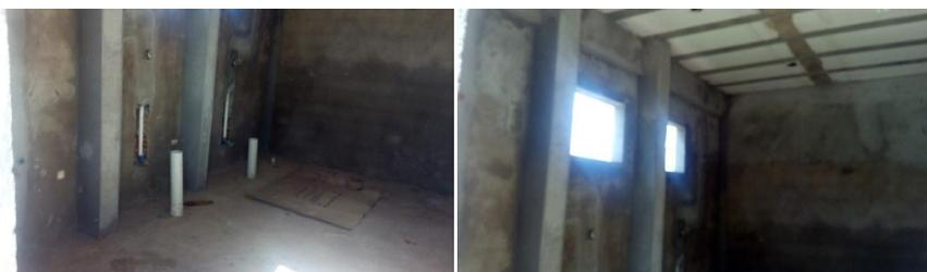
Teto sem chapisco, reboco e pintura. Paredes sem pintura e esquadrias.
